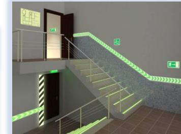
План и знаки, изготовленные из фотолюминесцентных материалов, обеспечивают возможность самостоятельной эвакуации работников в случае аварийного отключения источников света.
